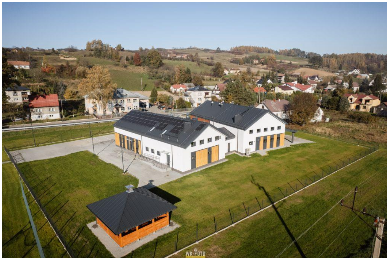
Zdjęcie nr 4. Kompleks wielofunkcyjny w Dąbrówce Tuchowskiej, przeznaczony na potrzeby Ochotniczej Straży Pożarnej oraz na cele społeczno-kulturalne
