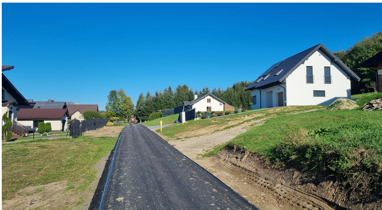
Zdjęcie nr 1. Modernizacja ul. Przedmieście Górne w Tuchowie w ramach zadania pn. „Poprawa gminnej infrastruktury drogowej poprzez kompleksową modernizację i przebudowę dróg gminnych w gminie Tuchów- etap II”
